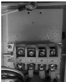
Рис.5 Подключение котла к электросети.
