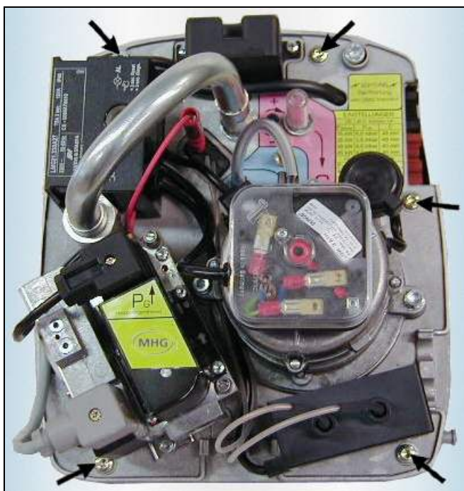
Рис. 10: Крышка корпуса с 5-ю быстрозакручивающимися винтами
