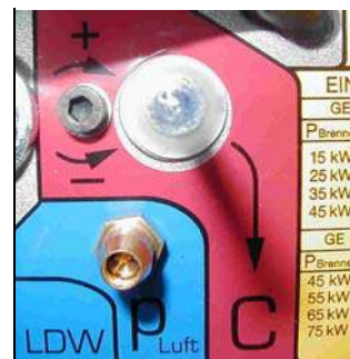
Рис. 19: Настроечный болт Logatop GE1H с мерной В- шкалой
