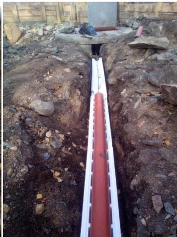
**Пенопласт применяют для изготовления трубной теплоизоляции различного диаметра от 25мм. до 1500мм..**
