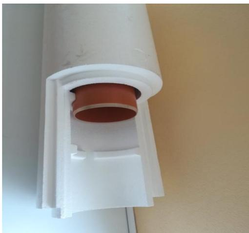
Теплоизоляция для трубы диаметром 110мм. (канализационная 110)
